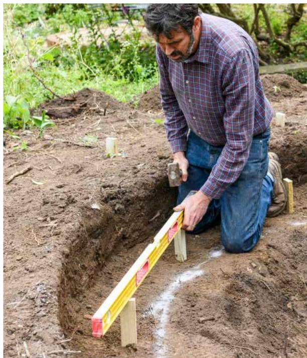
**4** Ensuite, enfoncez une série de piquets juste à l'extérieur de la ligne de peinture afin d'indiquer le niveau de béton à couler. J'ai placé les piquets 13 cm plus bas que le niveau du sol à l'extérieur afin de couler le béton, le mortier, d'installer le revêtement de bassin et celui en caoutchouc.
