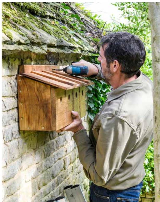
**21** Fixez le nichoir à l'aide de vis de 60 mm et de chevilles. J'ai placé le mien sur un mur semi-ombragé.
