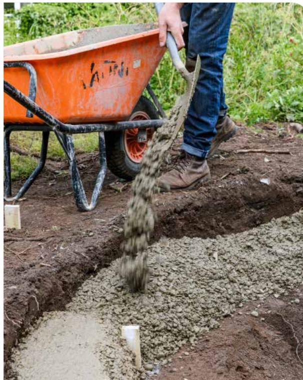
**5** Ensuite, coulez le béton sur tout le pourtour du bassin afin d'obtenir une surface plane et solide pour construire le muret en pierre. Mélangez le béton de manière à ce qu'il soit assez humide, puis versez-le à une profondeur d'environ 8-10 cm. Tassez-le au fur et à mesure avant qu'il ne prenne.
