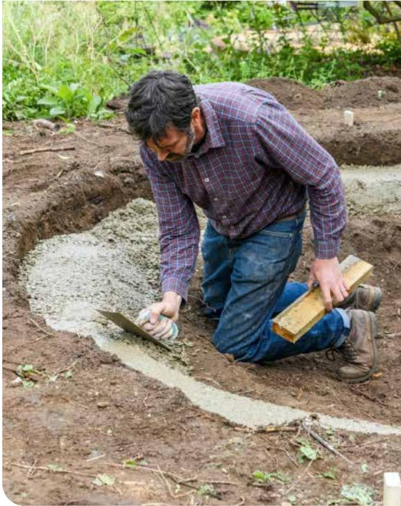
**6** Utilisez ensuite une truelle de maçon pour façonner le béton autour du bassin.
