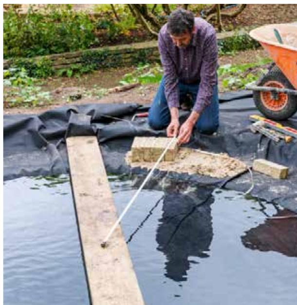
**14** Appliquez le mortier un jour ensoleillé, où il ne risque pas de pleuvoir. Utilisez le mètre ruban comme l'aiguille d'un cadran solaire afin qu'il serve de guide pour la circonférence du bassin. Posez un lit de mortier sur le revêtement et disposez les pierres tout autour, en veillant à ce qu'elles soient bien ajustées. Ne vous préoccupez pas des joints à ce stade. J'ai disposé ici les pierres sur leur bord pour former un cercle serré.
