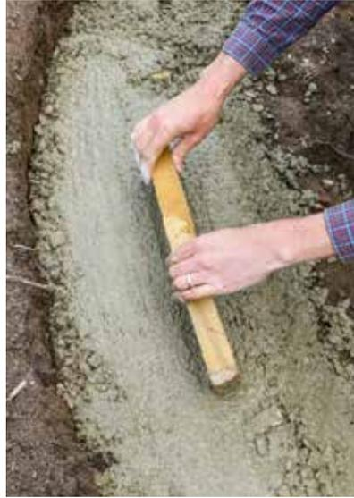
**7** Tassez le béton avec un morceau de bois, en utilisant les piquets comme guide pour niveler tout le contour. Laissez-le sécher pendant au moins 24 heures.
