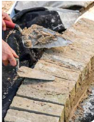
**18** À l'aide d'une petite truelle, remplissez les espaces entre les pierres avec du mortier, en veillant à les remplir de manière régulière. J'ai utilisé un sable fin de couleur claire mélangé à du ciment blanc pour que la couleur des joints se marie bien avec les pierres.
