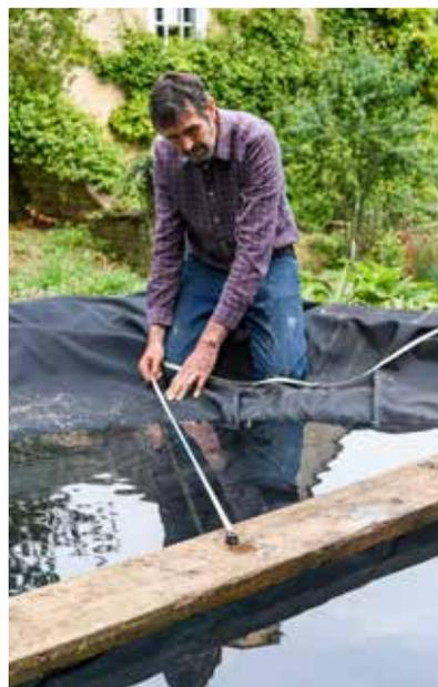
**13** Fixez une vis au centre d'une longue planche de bois et attachez-y un mètre ruban. Positionnez la planche de manière à ce qu'elle passe par le centre du bassin afin de vérifier les mesures. Cette mesure servira de guide pour le muret extérieur. Ajustez-la au besoin.
