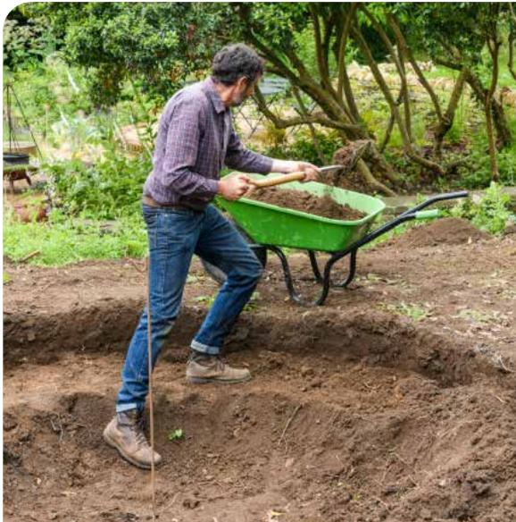
**1** Attachez un cordeau de 1,60 m de long à un piquet au centre du bassin et utilisez-le pour mesurer la circonférence. Creusez un trou de 70 cm de profondeur environ, en commençant par l'endroit le plus profond. Formez une marche d'environ 30 cm de profondeur et 40 cm de largeur.
