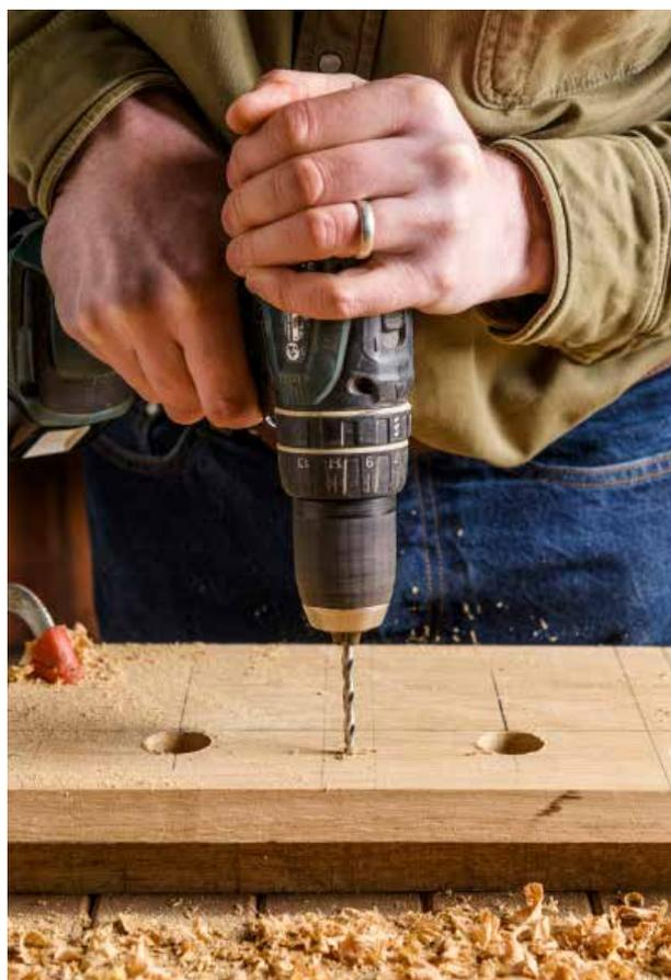
**7** Si ce n'est pas encore fait, marquez et percez les trous de fixation à 6 cm sur le panneau frontal et à 14 cm du centre inférieur de la zone décorée.
