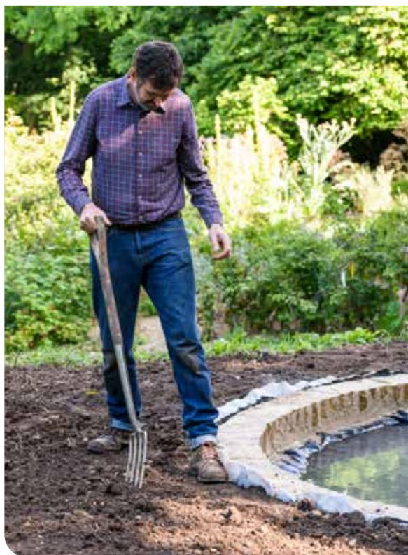
**20** Nettoyez l'excédent de mortier sur le revêtement. Remblayez ensuite la terre autour du bord de manière que les pierres soient au niveau du sol. La terre permet également de cacher le bord du revêtement et de le maintenir en place.
