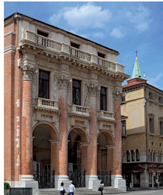
Immeubles sur rue
